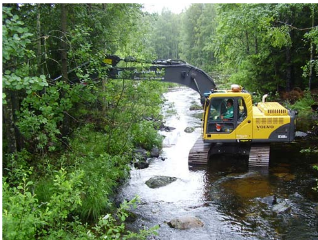
Restaurering av ett vattendrag med hjälp av grävmaskin, man återför stora stenar som tidigare rensats bort.
